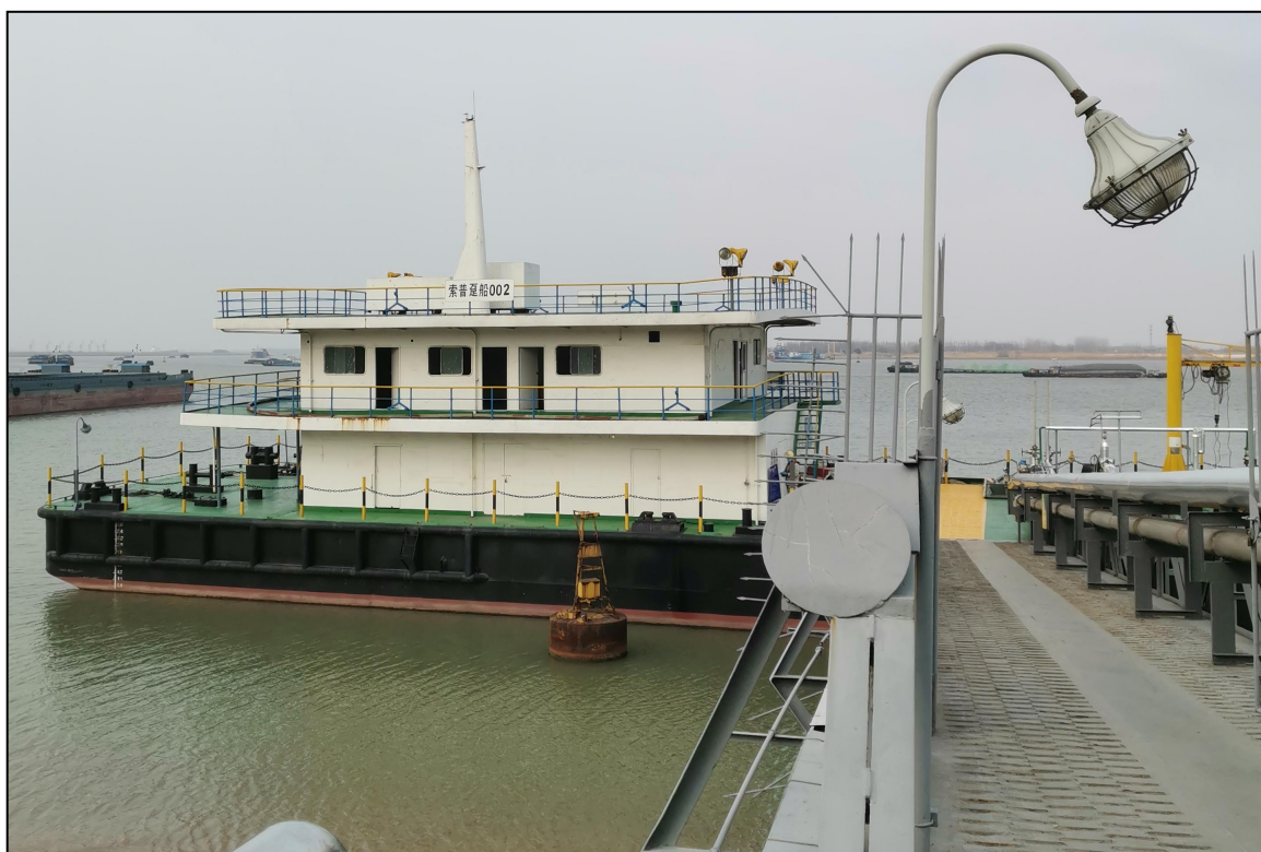
图 3.3-1 趸船码头现场照片
