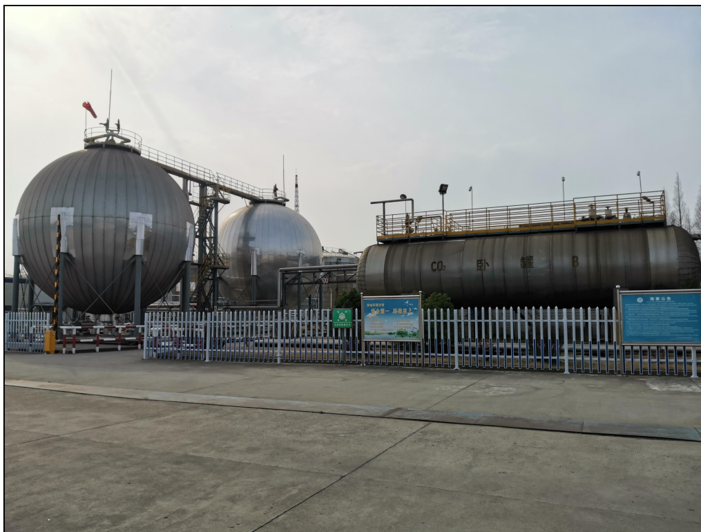
图 3.2.1 二氧化碳罐区现场照片
