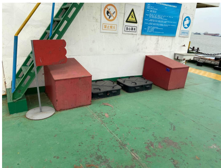
图 3.3-5 码头平台消防沙箱现场照片
